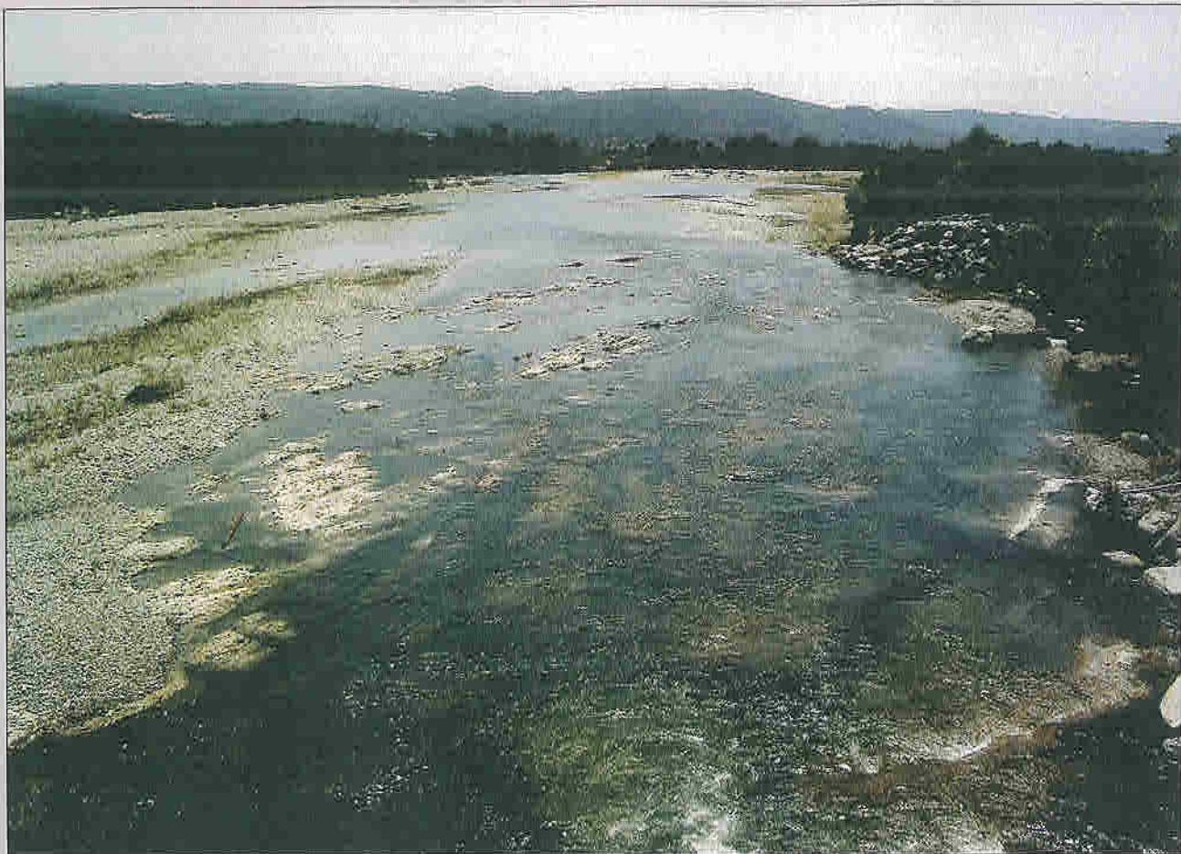
Dans les cas extrêmes d'incision, le cours d'eau peut s'enfoncer jusqu'à atteindre la roche-mère, comme ici sur la moyenne Durance aux environs de Sisteron. Des exemples similaires sont assez nombreux en France.
