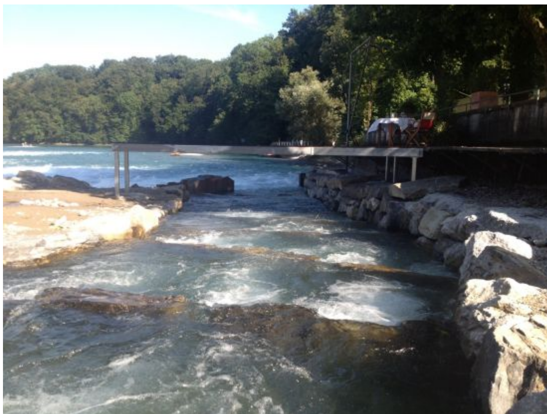
Fig. 2: Les passes à poissons permettent le franchissement des ouvrages hydroélectriques vers l'amont. Des grilles et des systèmes de déviation aident à protéger les poissons des turbines lors de la dévalaison.
