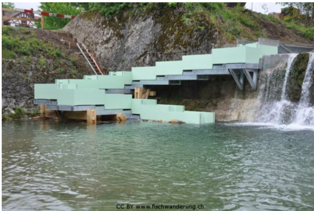
Figure 1 : La Steffstep est constituée de plusieurs éléments individuels et peut donc être facilement installée et démontée en fonction des besoins (Photo: www.fischwanderung.ch ).
